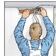
5. Überstände an Decken, Fußleisten, Fenstern usw. mit dem Cuttermesser und dem Tapezierspachtel abtrennen.
